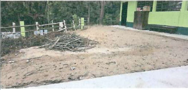
Foto 4: Espacio donde se va a hacer la losa de patio.
