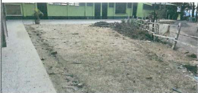
Foto 3: Espacio donde se va a hacer la losa de patio.
